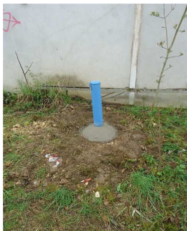
Sécurisation de l'ouvrage T5
