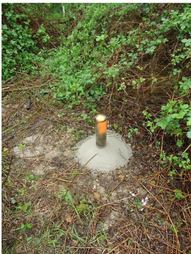
Sécurisation de l'ouvrage P1
