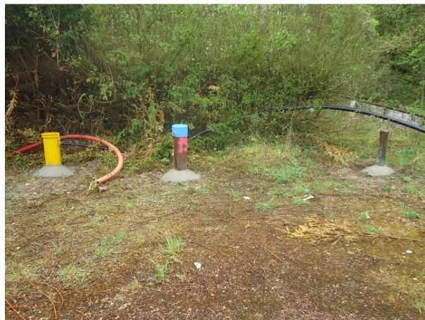
Sécurisation des ouvrages P4, P5 et P3 (de gauche à droite)
