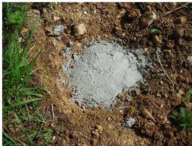
Ouvrage T8 rebouché
